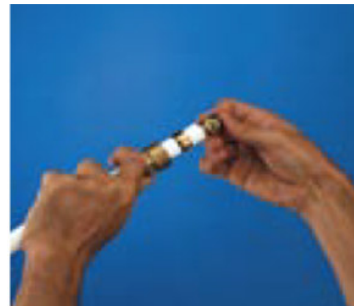
4. Se introduce fittingul pe teava.
