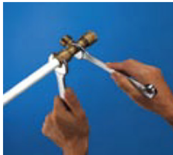
5. Piulitele fittingului se strang cu cheia.
